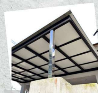
PU Metal Deck
